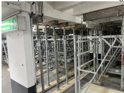
Étais mis en place dans le parc de stationnement sous le site des Invalides
