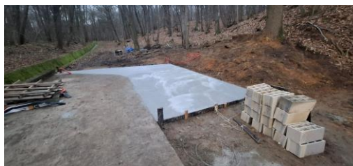
Réfection de la dalle de béton
