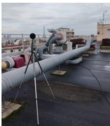
Sonomètre pour la mesure du bruit sur le toit
